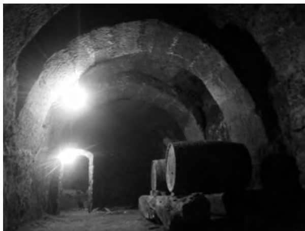
Figura 10. Un cubillo salva una bodega. Nave en Fuentespina.
